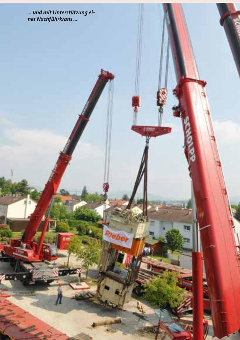
Der Demag AC 650 war bereits am Vortag mit 160 t Ballast sowie der 10 t schweren Abspannung gerüstet worden und stand fertig an seinem Einsatzort links vor
